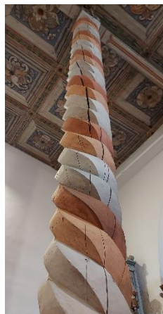
2. Výborná pilier/oporný stĺp
